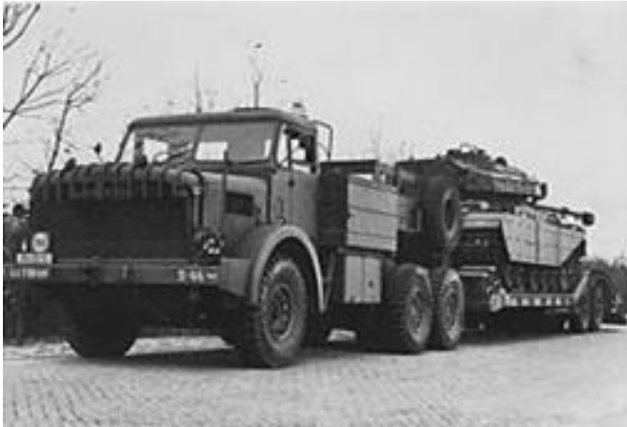
Thornycroft Mighty Antar trekker 20 ton 6 x 4 Met Centurion tank ca. 1974
